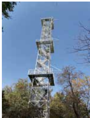
城市生态环境观测梯度通量塔
