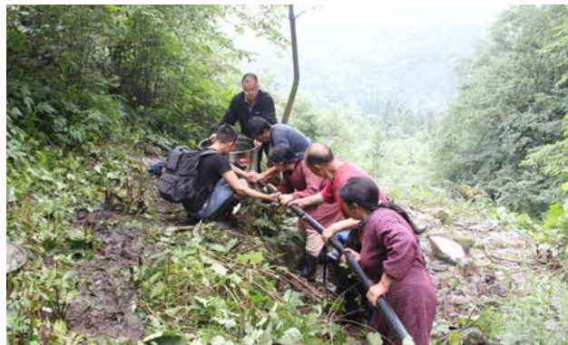
龙池园区供水系统改造
