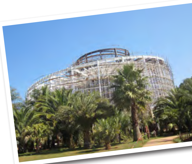
温室群主体建筑
