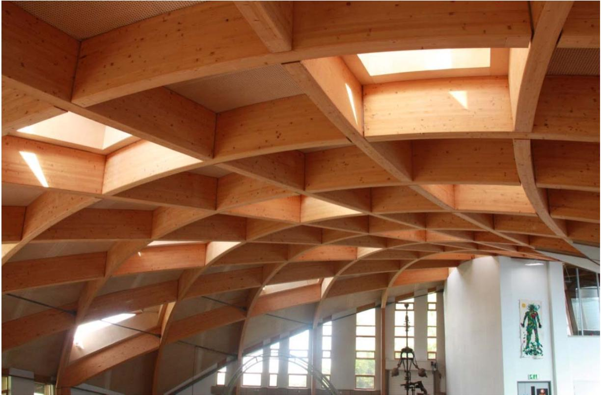
图16. 灵感来源于葵花的屋顶，自然光线可以通过屋顶的玻璃到达地面
