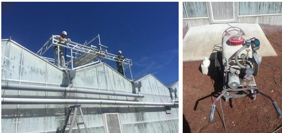
图 24 喷洒反光药剂现场及设备
