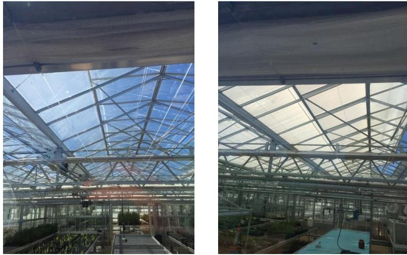
图 25 喷洒反光药剂前后对比
