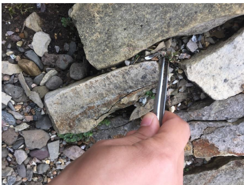
用镊子拔除石缝里的杂草
