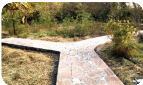
吐鲁番鸢尾专类园道路铺设
