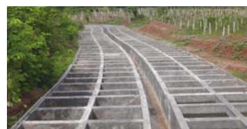
新建水生植物保育池
